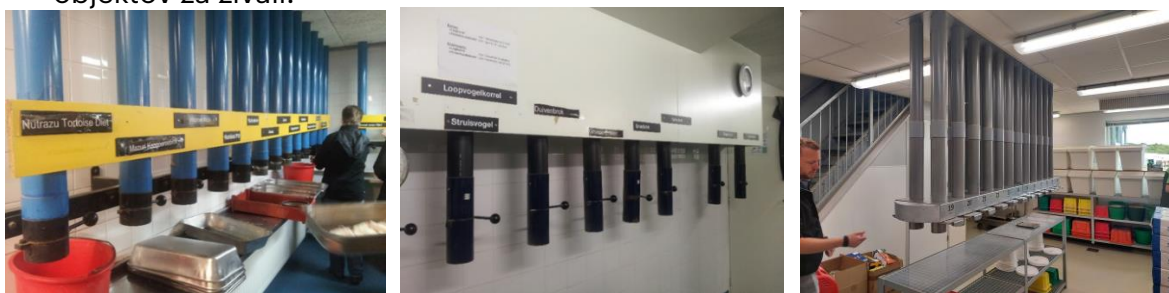
Slika 13: Silosi za brikete v nadstropju (polnjenje silosov)
