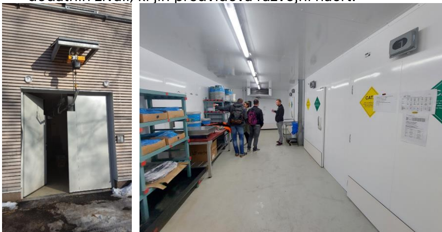
Slika 4: transportno vodilo za klavne trupe, Slika 2: hladilnica kot predprostor zmrzovalnice
